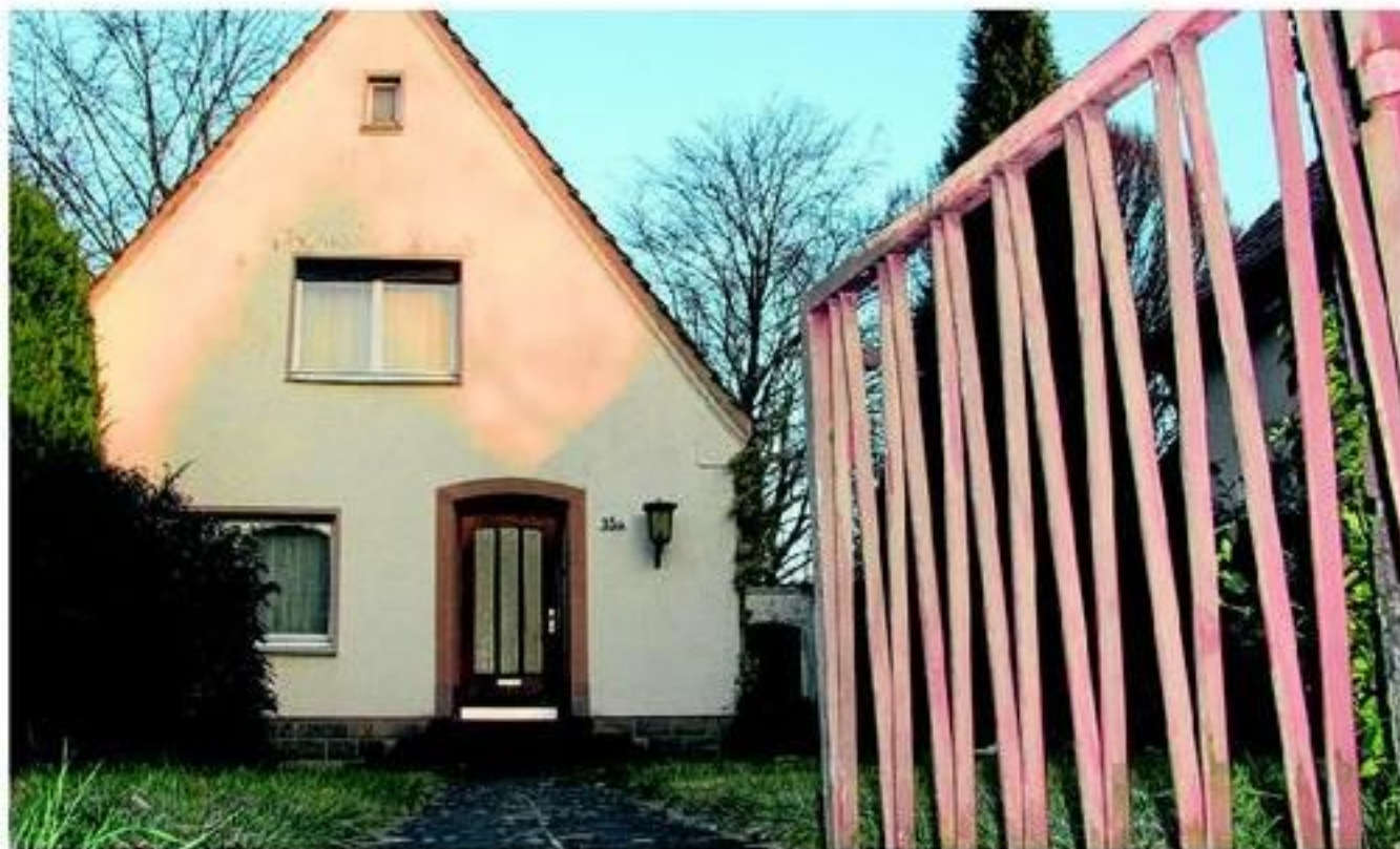
Müssen weichen: Dieses und ein benachbartes Haus werden an der Heldmanstraße abgerissen, um Platz für einen Neubau mit Apartments und Wohngruppe zu machen.
