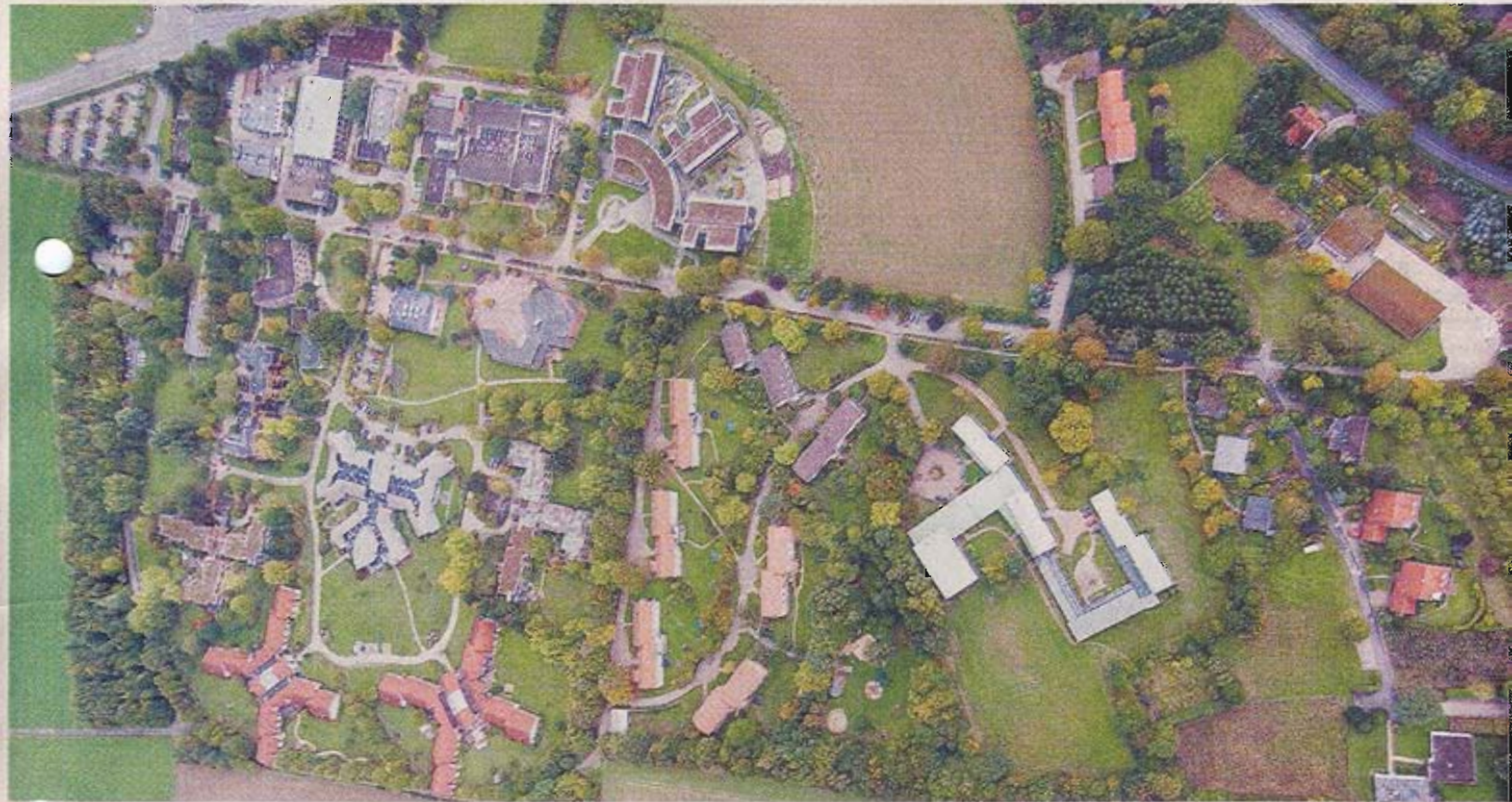
Lemgoer Stadtteil: Das Luftbild (noch ohne die neue Turnhalle in Nachbarschaft der Topehlen-Schule) zeigt Neu Eben-Ezer an der B238 (links oben zu erk. Norden von Lemgo. 1957 wurde hierfür der Grundstein gelegt. Künftig soll sich das Gebiet noch mehr zur Stadt hin öffnen.
